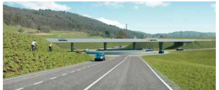
Die Fahrspur für den Verkehr von Glattfelden führt in den abgesenkten Kreisel.
